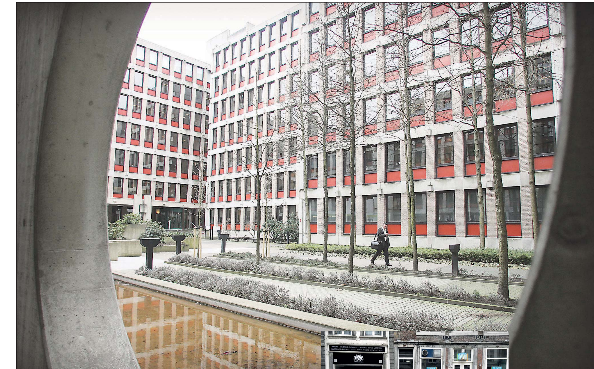
Het voormalige kantoor van CBS in Heerlen. Bijna 45.000 vierkante meter staat leeg.
